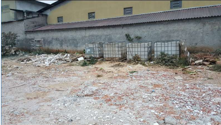
Figura 08 – Armazenamento de sobras e resíduos
